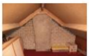
2 e Verdieping; open zolderruimte
