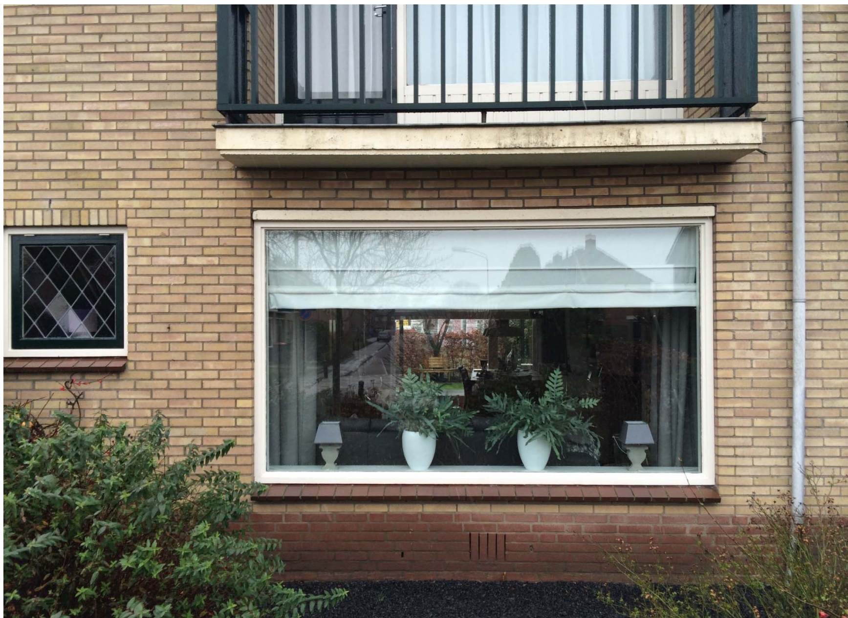
Woning Het Jebbink 37 te Vorden – kozijn voorgevel -foto bestaande situatie (2)-
