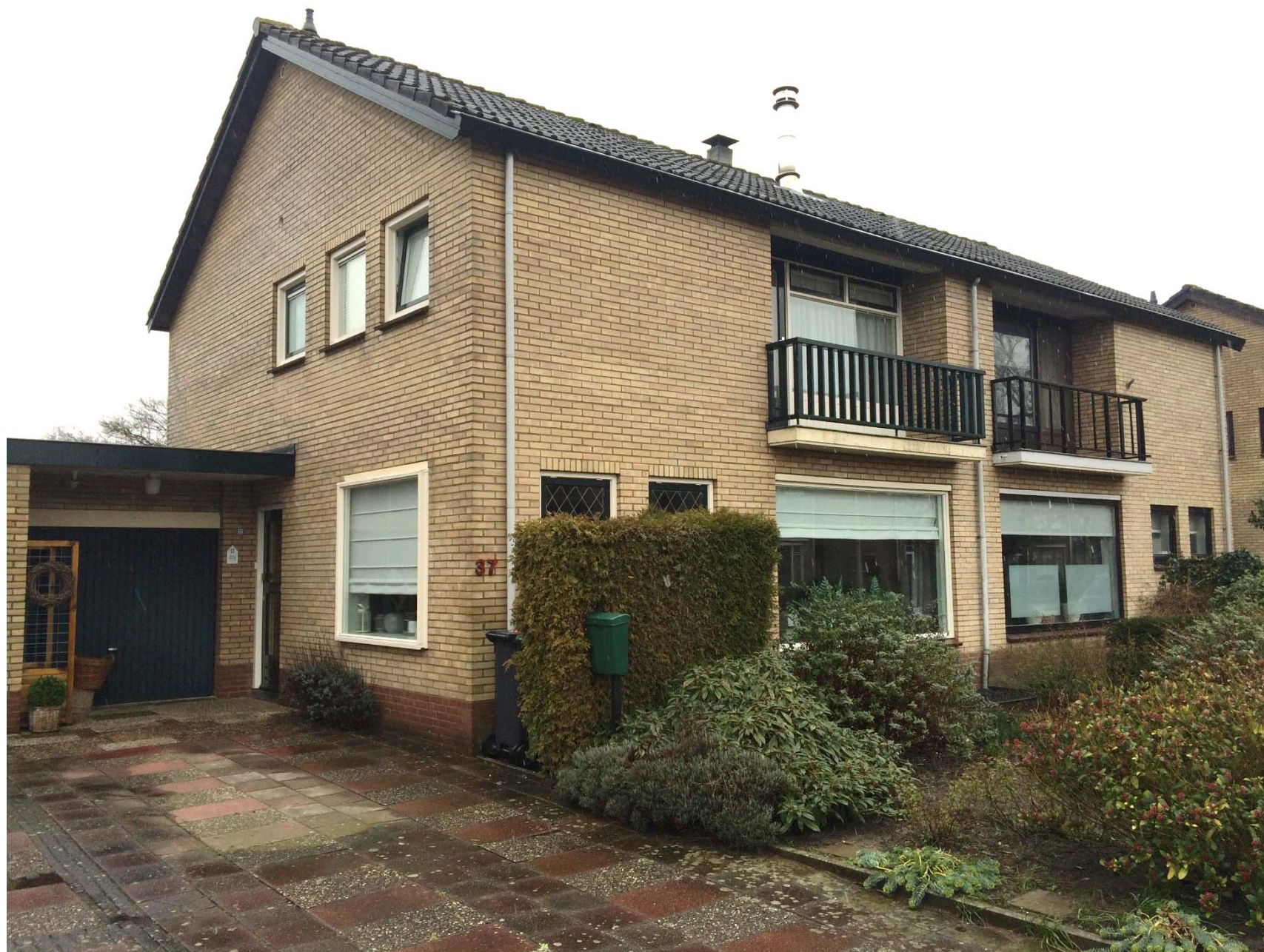
Woning Het Jebbink 37 te Vorden – kozijn voorgevel -foto bestaande situatie (1)-
