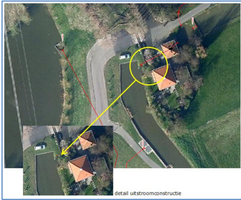
Overzicht gemaal en uitstroomconstructie
