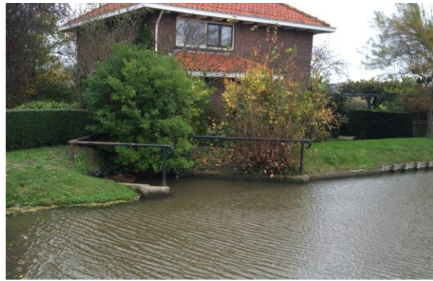
Foto te verwijderen uitstroomconstructie
