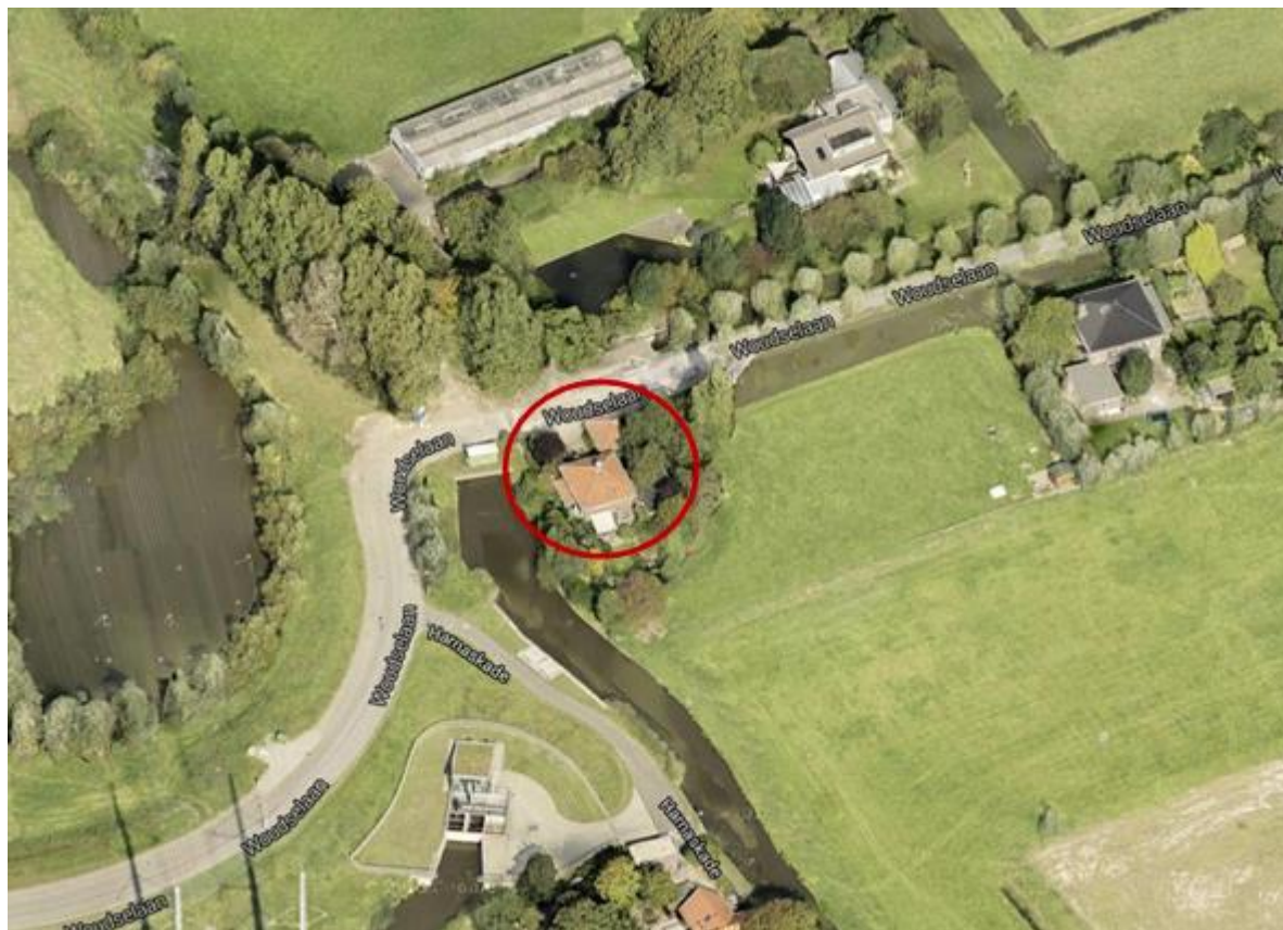
Gemaal Eensgezindheid aan de Woudselaan
