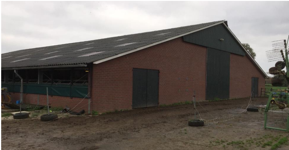
Te verbouwen ligboxenstal achtergevel
