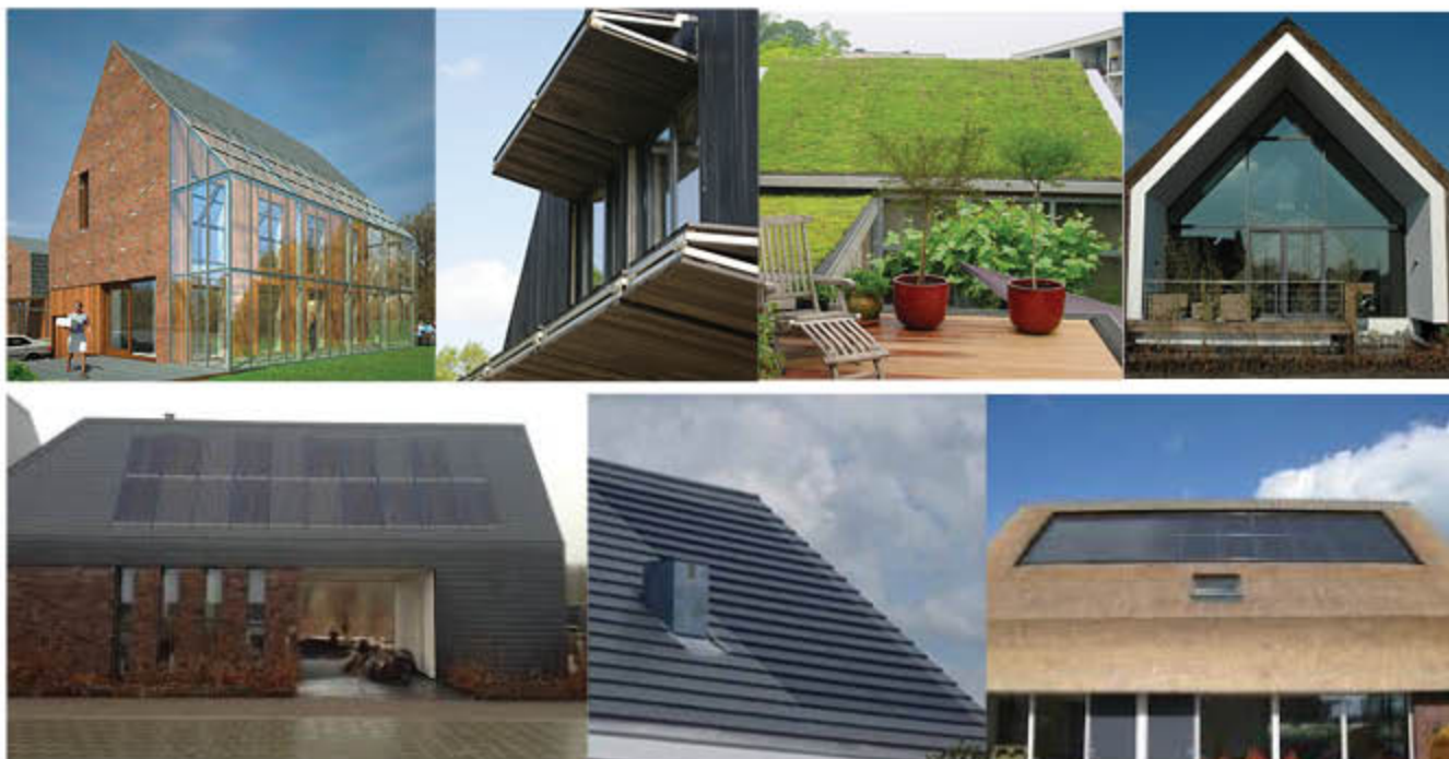
voorbeelden duurzaamheid: serre - luiken - groene daken - overstek en zonnepanelen intergraal ontworpen in het dakvlak
