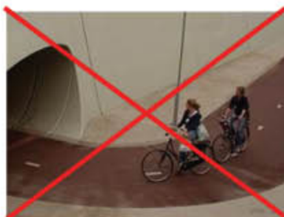
ontbreekt aan zicht de tunnel in
