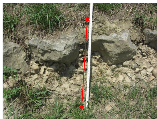
Figuur II-11 Ondergraven zetsteen bij 41,6 (rode pijl = 60 cm)
