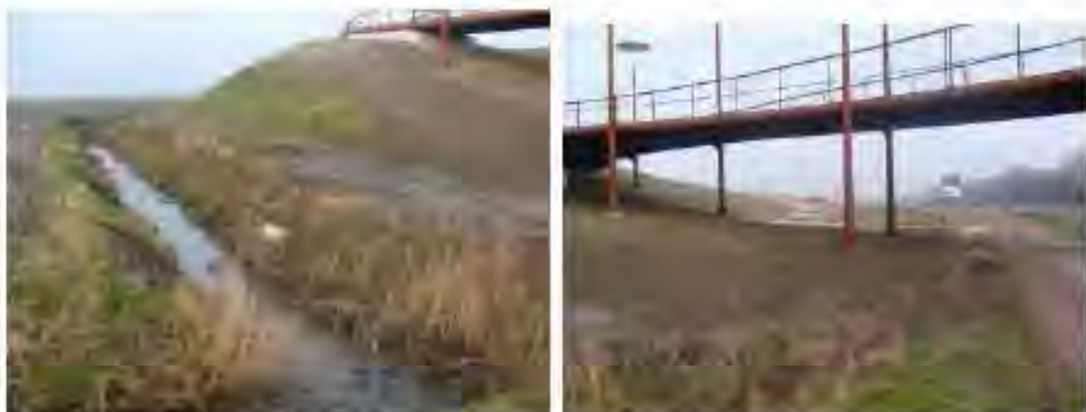
Foto's huidige grondterp rondom fundatie Fietsbrug
