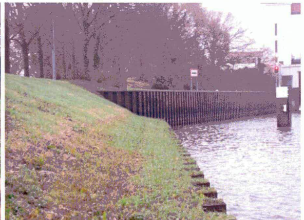
Damwand aan voet van de waterkering, als grens met de voorhaven
