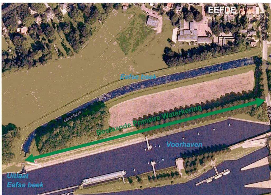
Figuur 1-3 Overzicht sluiscomplex bij Eefde en Primaire Waterkering (groene lijn)
