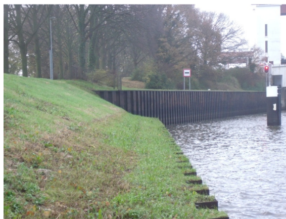
Damwand aan voet van de waterkering, als grens met de voorhaven
