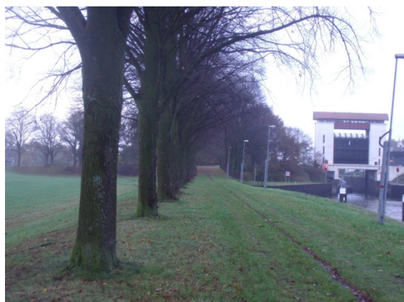
Waterkering in oostelijke richting, benedenhoofd bestaande sluis kolk rechts op achtergrond
