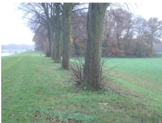
Waterkering in westelijke richting, uitlaat Eefse beek links op de achtergrond
