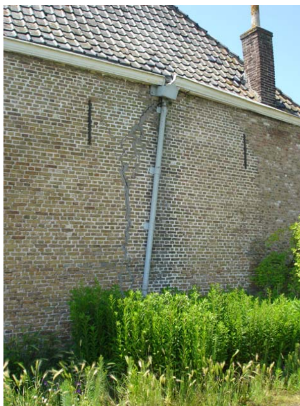
Aangetaste blokkeel
