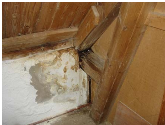
Aangetaste blokkeel
