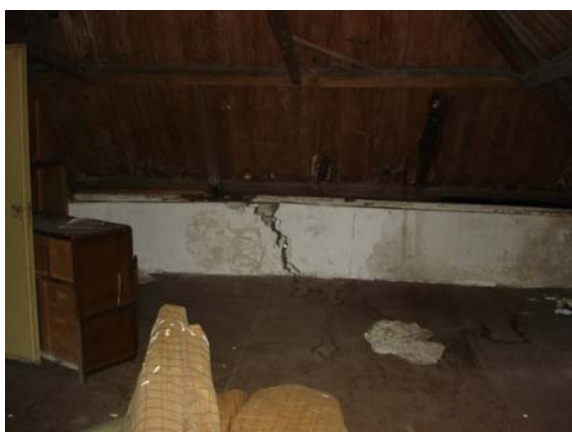
Scheurvorming in borstwering zijgevel
