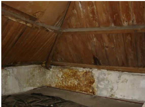
Beeld zolder: lekkage, aangetaste gordingen, Beeld van de lekkage rondom de schoorsteen Keper, dakbeschot en muurplaat
