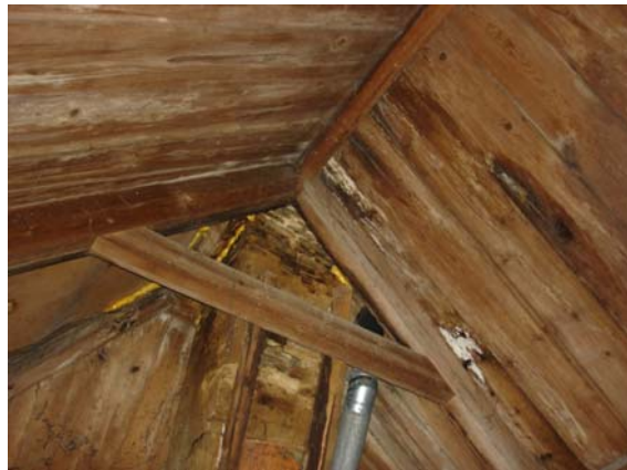
Beeld zolder: lekkage, aangetaste gordingen, Beeld van de lekkage rondom de schoorsteen Keper, dakbeschot en muurplaat
