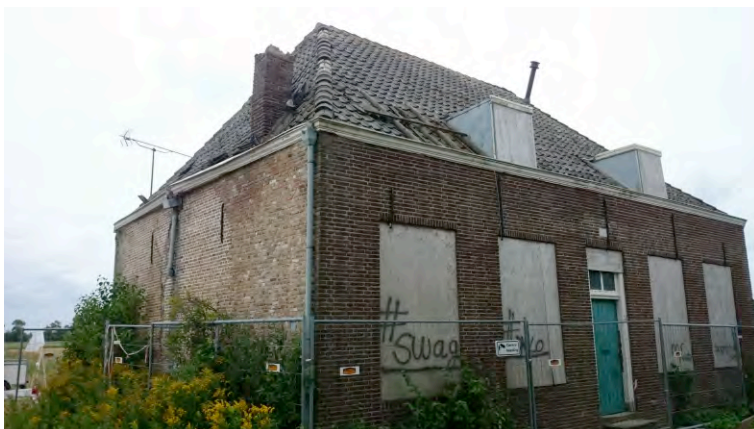
Te renoveren/restaureren boerenwoning.
