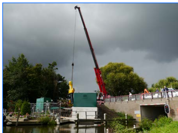
Levering vispasseerbarepomp, gemaal Kralingseplas
