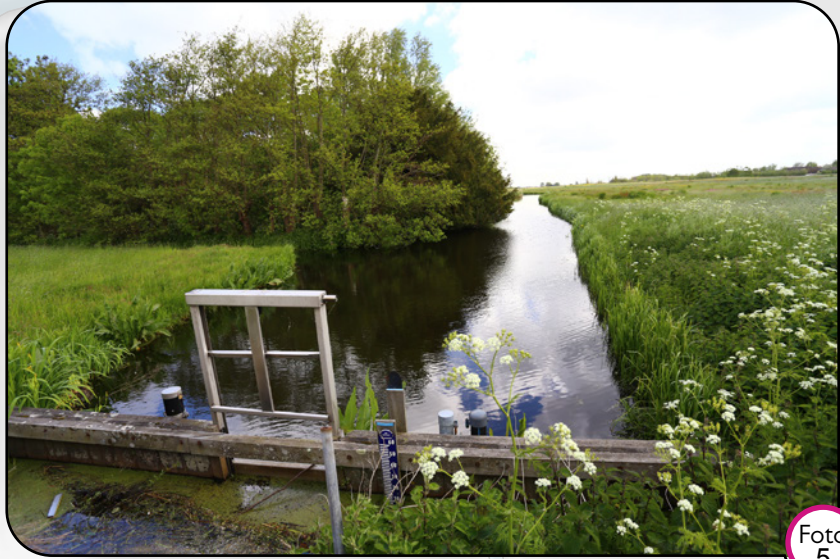
Stuw in Oude Leede
