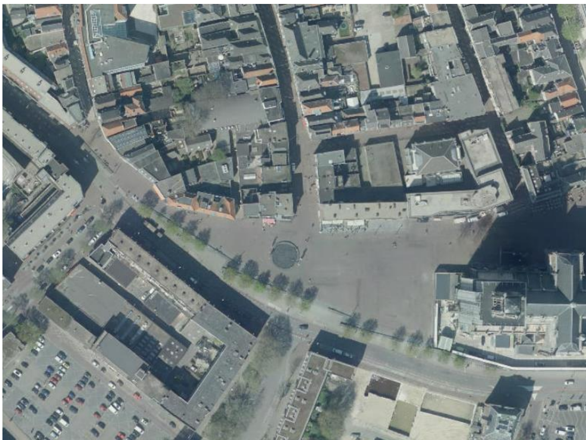
Afbeelding 2.7 Luchtfoto huidige situatie
