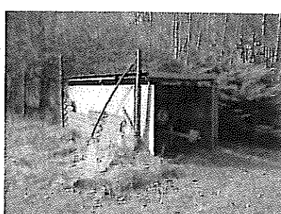
Schuurtje met asbestplaten
