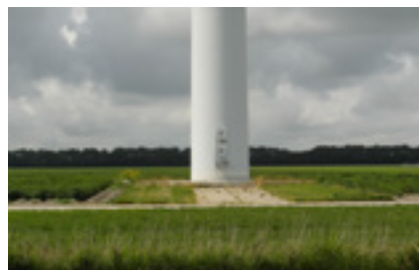
Techniek verwerkt in de mastvoet
