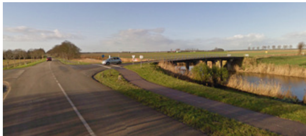
Brug over een vaart, met lichte uitbuiging van de weg.
