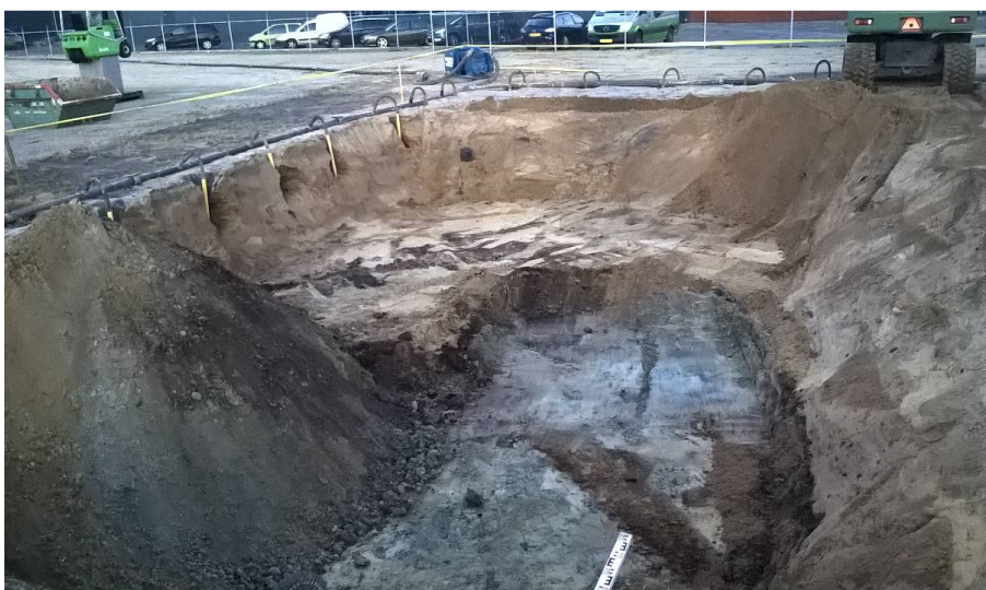
foto 3: put na verwijdering 'schone' bovengrond en een klein deel van de verontreiniging
