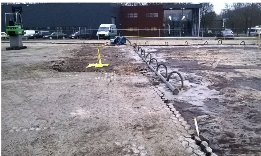
foto 2: overzicht locatie na aanbrengen bronnering
