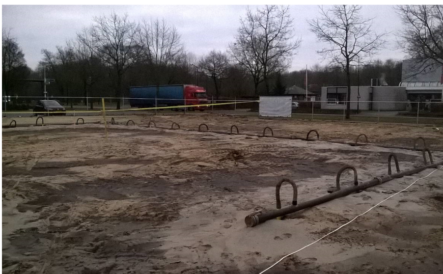
foto 1: overzicht locatie na aanbrengen bronnering
