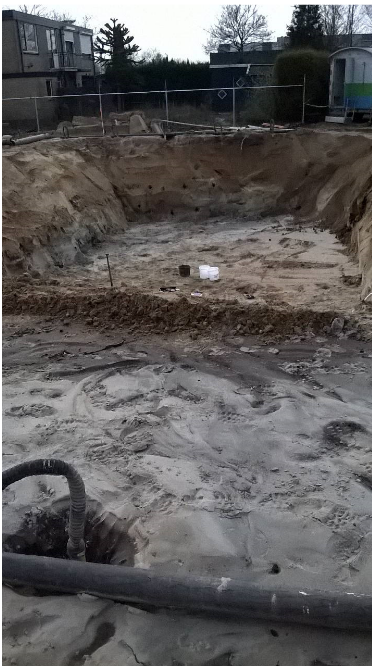
foto 6: put na ontgraving
