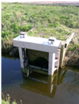
Figuur 8 Voorbeelden stuwput met duiker (bron: HC-Waterbeheersing en KWT)
