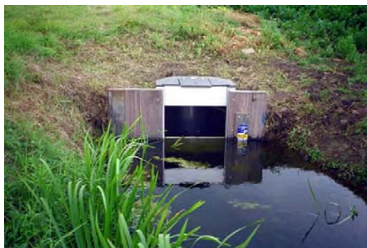
Figuur 8 Voorbeelden stuwput met duiker (bron: HC-Waterbeheersing en KWT)
