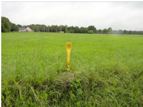
Figuur 13 Leidingen Gasunie op locatie Gouwberg
