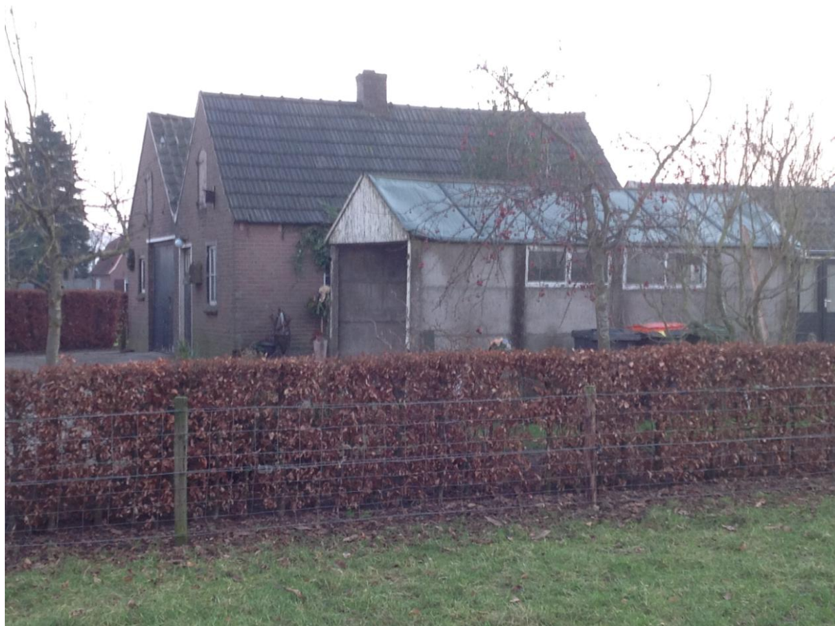
Bestaande schuren Hogenkampweg 7 7255 JW Hengelo
