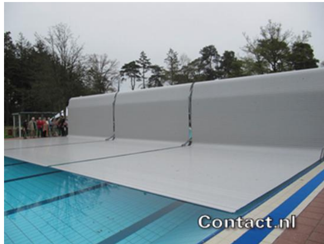
Volautomatisch systeem voor het in- en uitrollen van lamellen over de twee zwembassins
