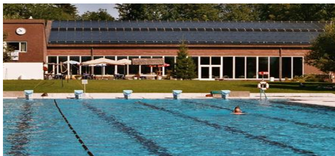
Zonnepanelen wekken elektriciteit op voor pompen en teruglevering op net.
