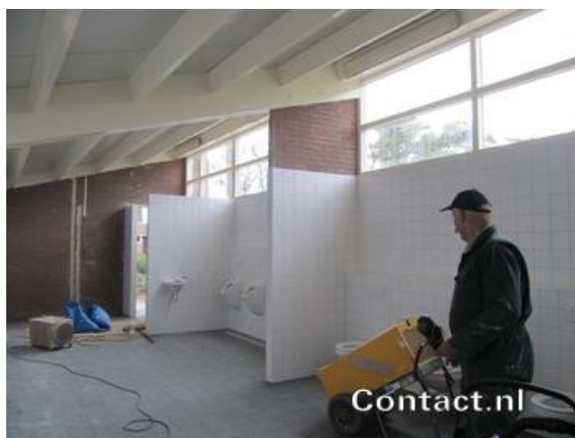
Vanwege hygiëne eisen renovatie van sanitair- en doucheruimte
