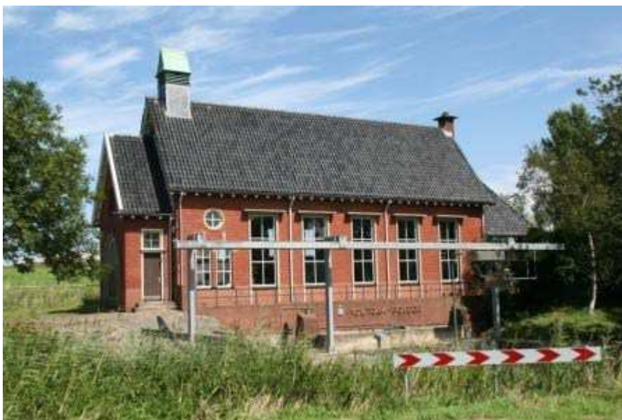
Figuur 4.13: gemaal Houtrakpolder
