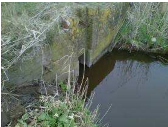
Figuur 4.9: stuw Uiterdijken naar Inlaagpolder
