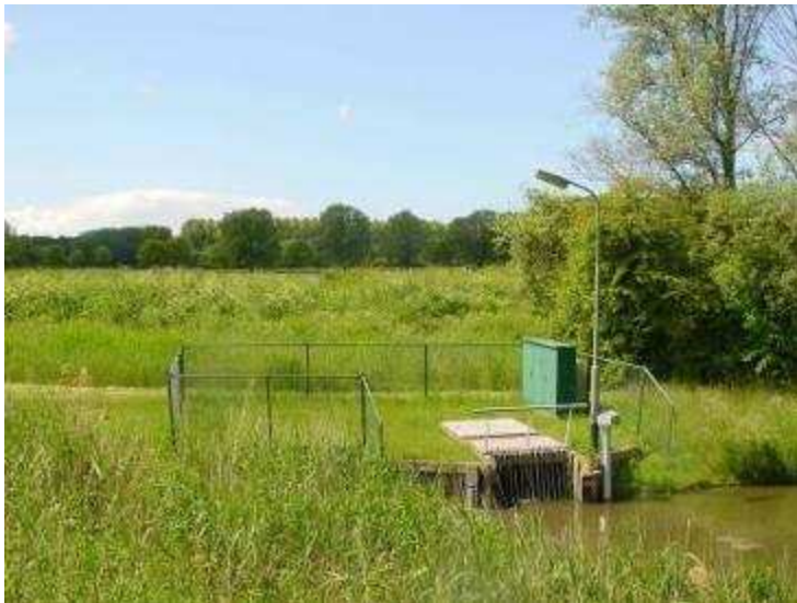
Figuur 5.13: gemaal Rijksweg 22
