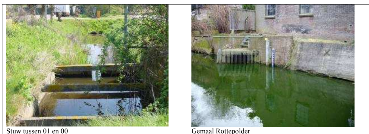
Figuur 6.15: stuw en gemaal Rottepolder
