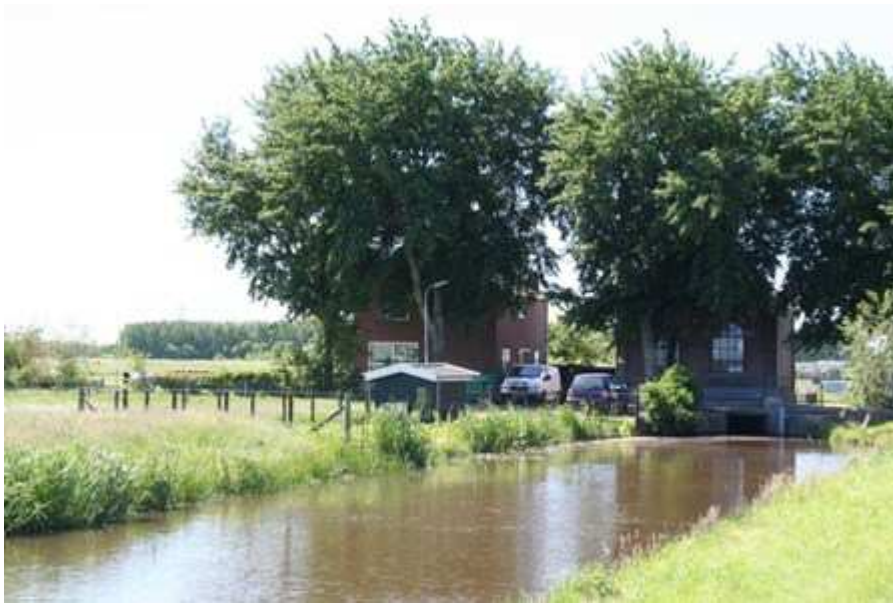
Figuur 4.8 gemaal Inlaagpolder
