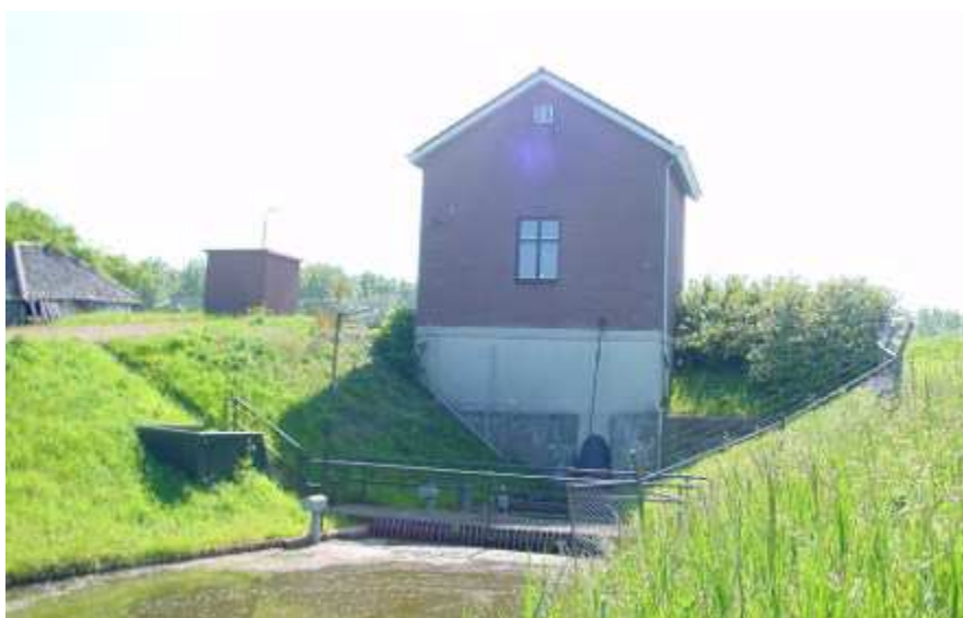
Figuur 5.10 gemaal Zuid-Spaarndammer
