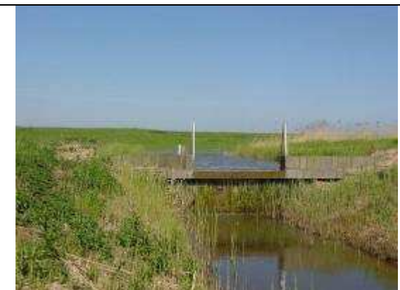
Stuw 306-056-00020 tussen Houtrakkerbeemden en Machinetocht
