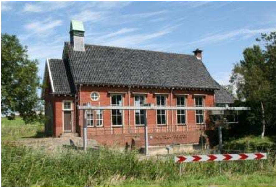
Figuur 4.13: gemaal Houtrakpolder
