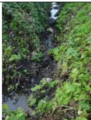
238-056-00001 doorgegraven dam met stuwende functie
