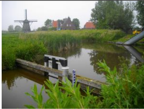
Stuw Veerplas richting gemaal
