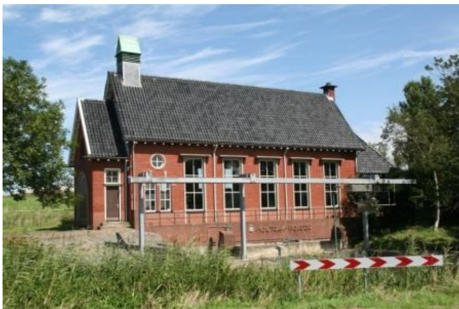
Figuur 4.13: gemaal Houtrakpolder
