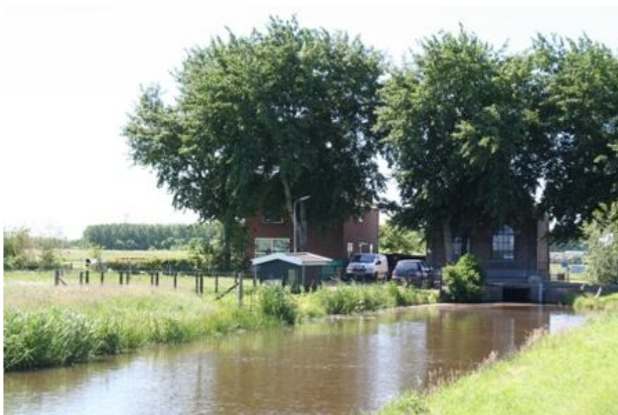
Figuur 4.8 gemaal Inlaagpolder
