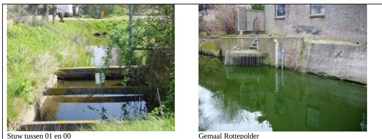
Figuur 6.15: stuw en gemaal Rottepolder
