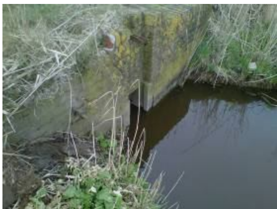
Figuur 4.9: stuw Uiterdijken naar Inlaagpolder
