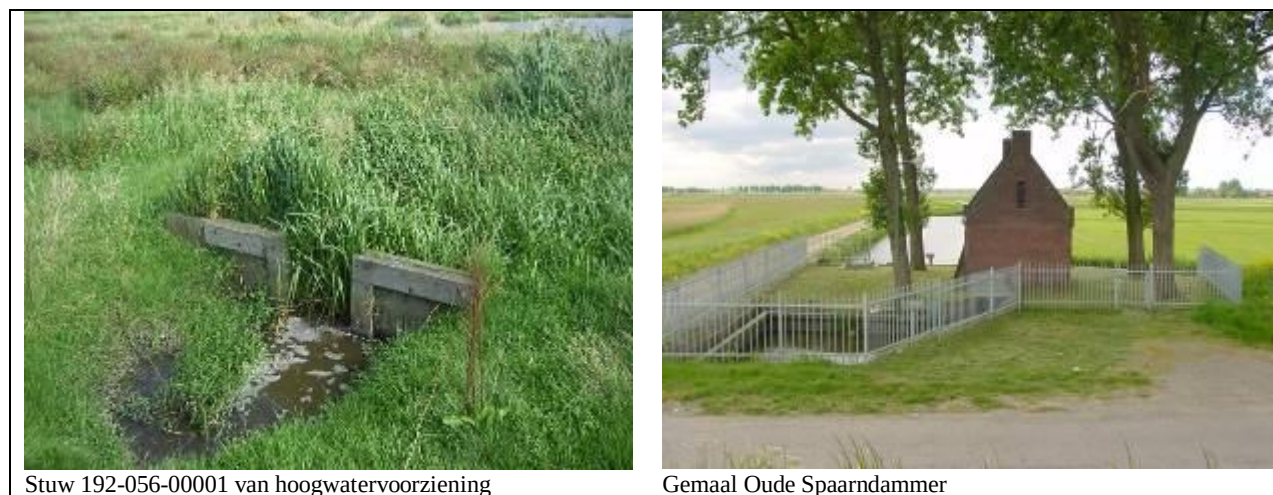
Figuur 5.24: stuw en gemaal in Oude Spaarndammerpolder
