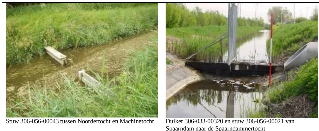
Figuur 4.18: stuwen in de Houtrakpolder
