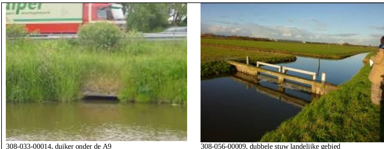
Figuur 5.19: duiker en dubbele stuw nabij A9
