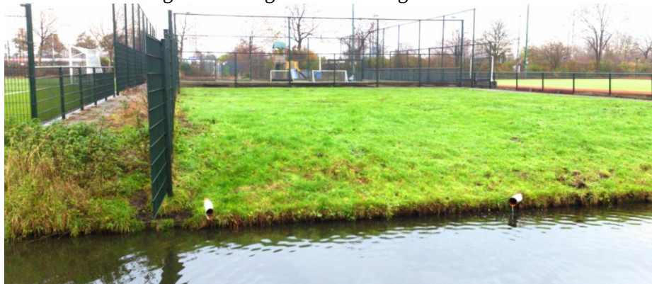
Figuur 14 De lozingspunten van drains in sportpark het Wedde liggen hoog genoeg voor een peilverhoging van 11 cm.
