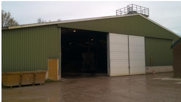
Productiehal betonelementen - stabilizer
