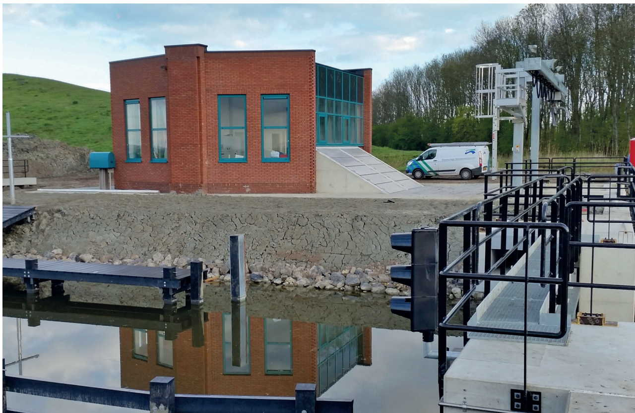
HET IN 2015 GEBOUWDE GEMAAL USQUERT
