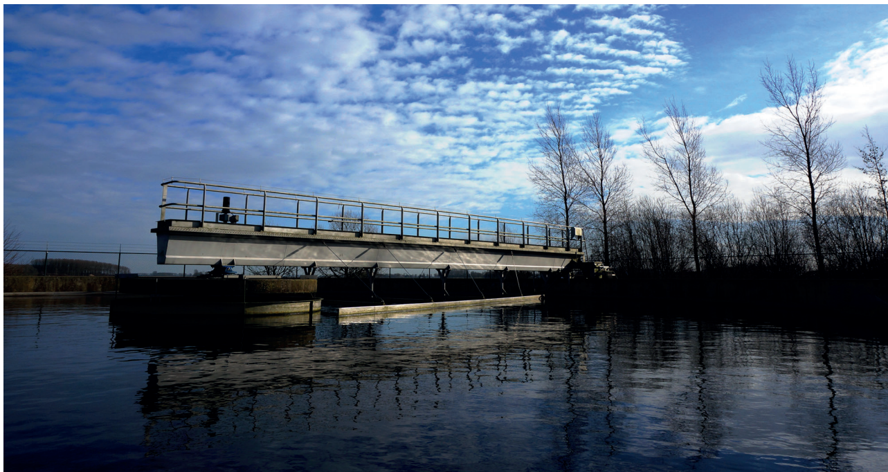
DE RIOOLWATERZUIVERING ULRUM
