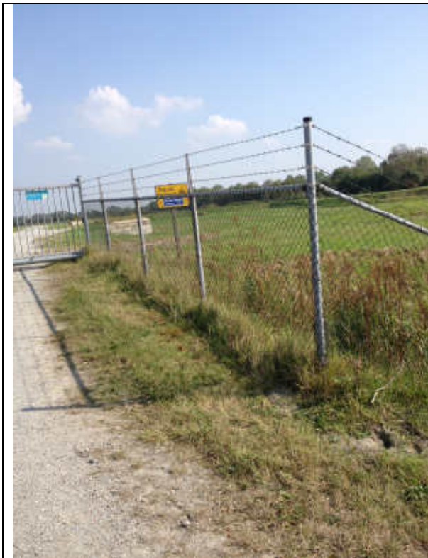
Foto 1) hekwerk 1,5 m hoog + 3 puntdraden
