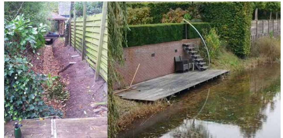
Ongewenste situaties: watergangen met een belangrijke afvoerfunctie moeten voor het waterschap toegankelijk zijn om te kunnen onderhouden (Bron: waterschap Brabantse Delta)
