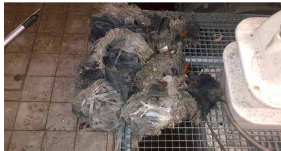
Vervuiling in de rioolwaterpersleiding bij Roosendaal (Bron: waterschap Brabantse Delta)
