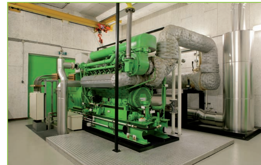
Biogasmotor Kralingseveer
