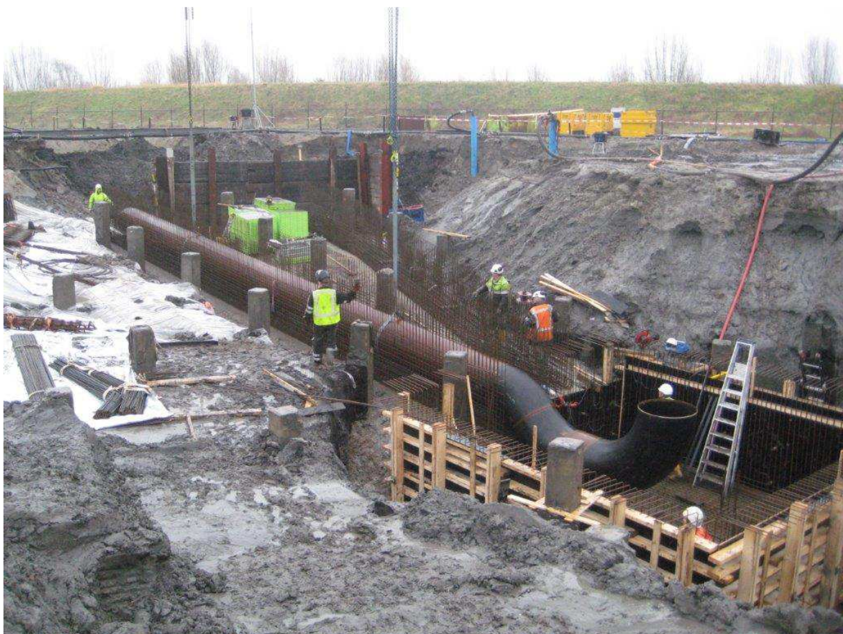
Renovatie RWZI Numansdorp
