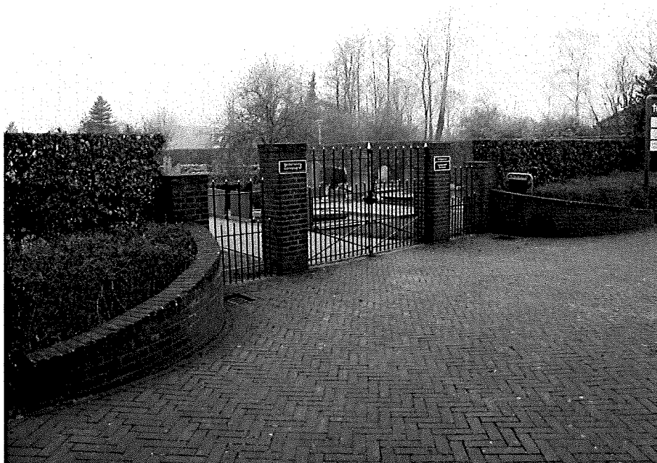
Entreepartij zijde Kerkhofweg, met beplanting en poort.
