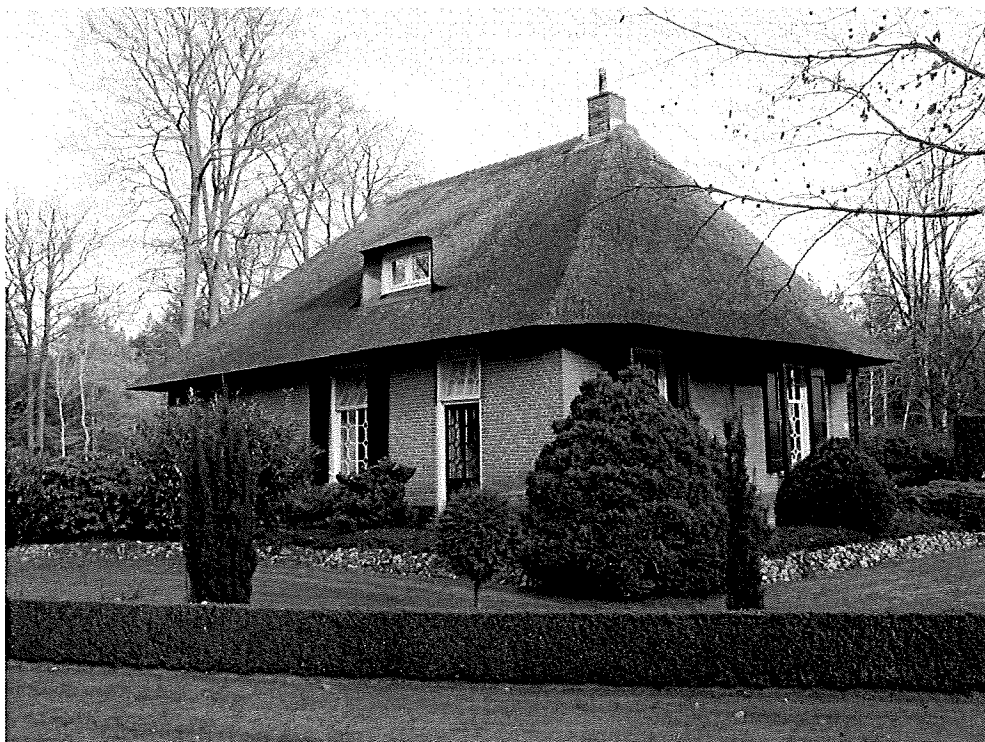
Historische beheerderswoning ten zuiden van de Algemene Begraafplaats, oostelijk van de toegangslaan, gefotografeerd vanuit het zuiden en zuidwesten.
