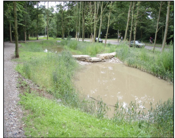
Afkoppelen regenwater zandweg
