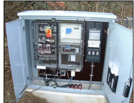
Schakelkast pompinstallatie
