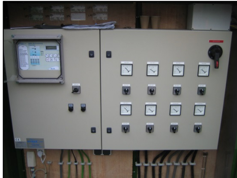
Schakelkast bergbezinkbassin
