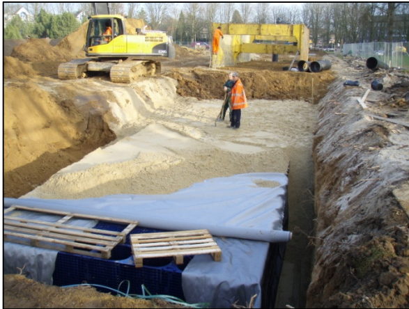
Infiltratiekratten Bekkerveld
