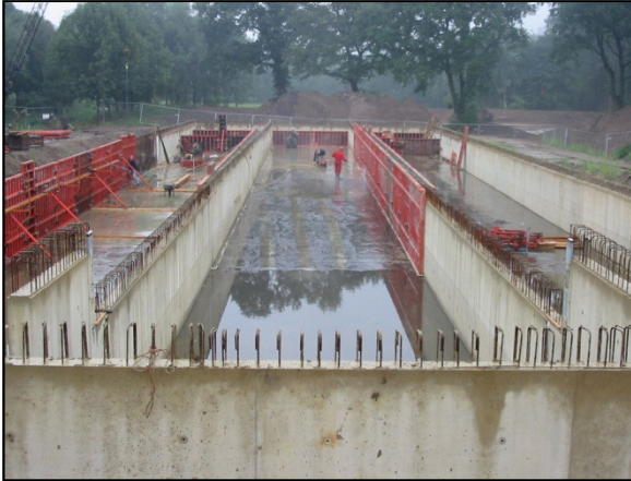
BBB in aanbouw
