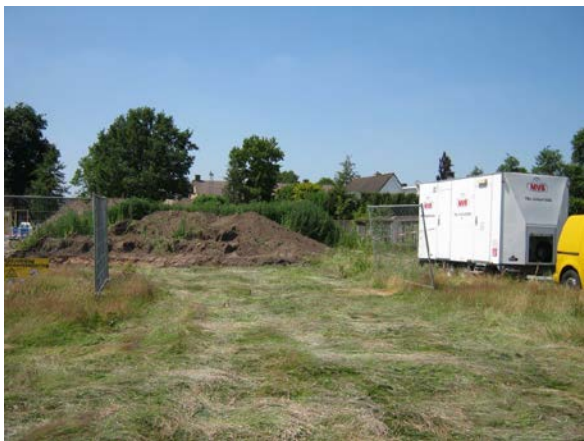
Foto 2: Hekwerk en plaatsen DECO unit
