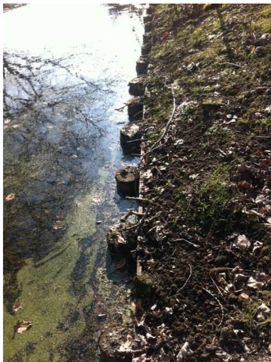
Figuur 11 - Voorbeeld van beschoeiing op waterlijn binnentalud-teensloot
