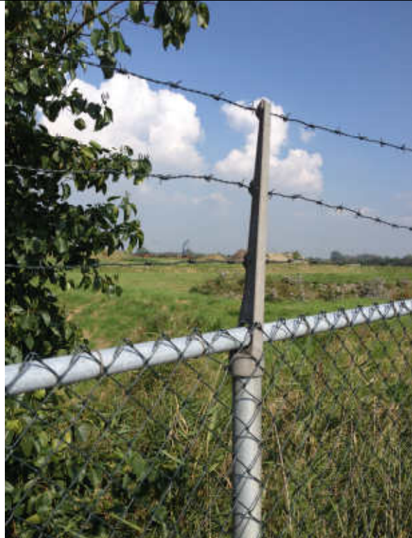
Foto 4) voorbeeld van constructie puntdraden
