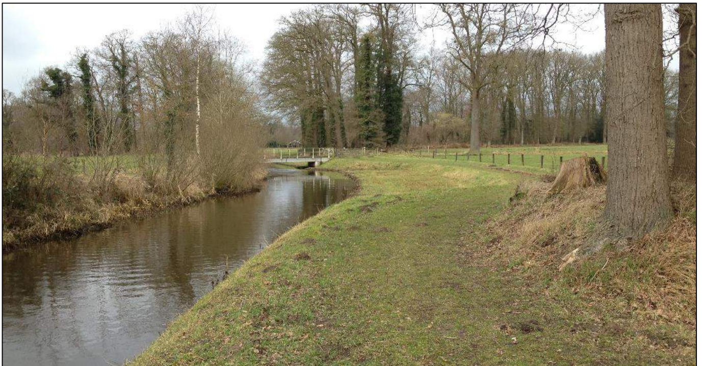
Figuur 1: Oude Bornschebeek met traditioneel cultuurtechnisch profiel, plasberm en (éénzijdige) beekbegeleidende beplanting.
