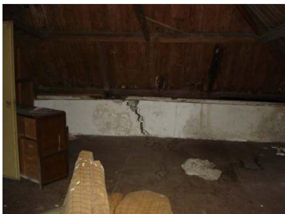
Scheurvorming in borstwering zijgevel
