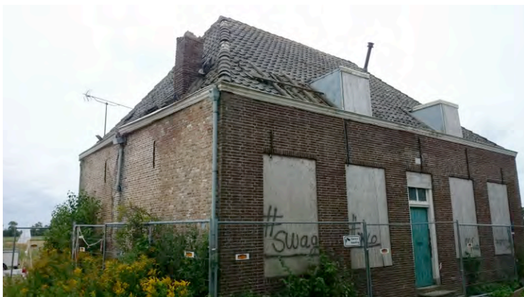
Te renoveren/restaureren boerenwoning.
