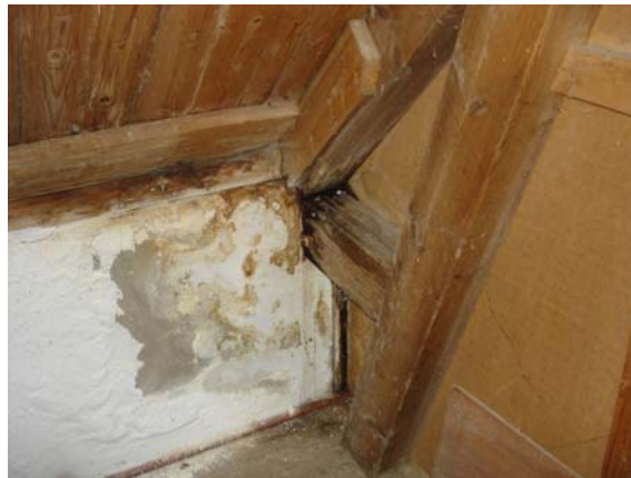
Aangetaste blokkeel
