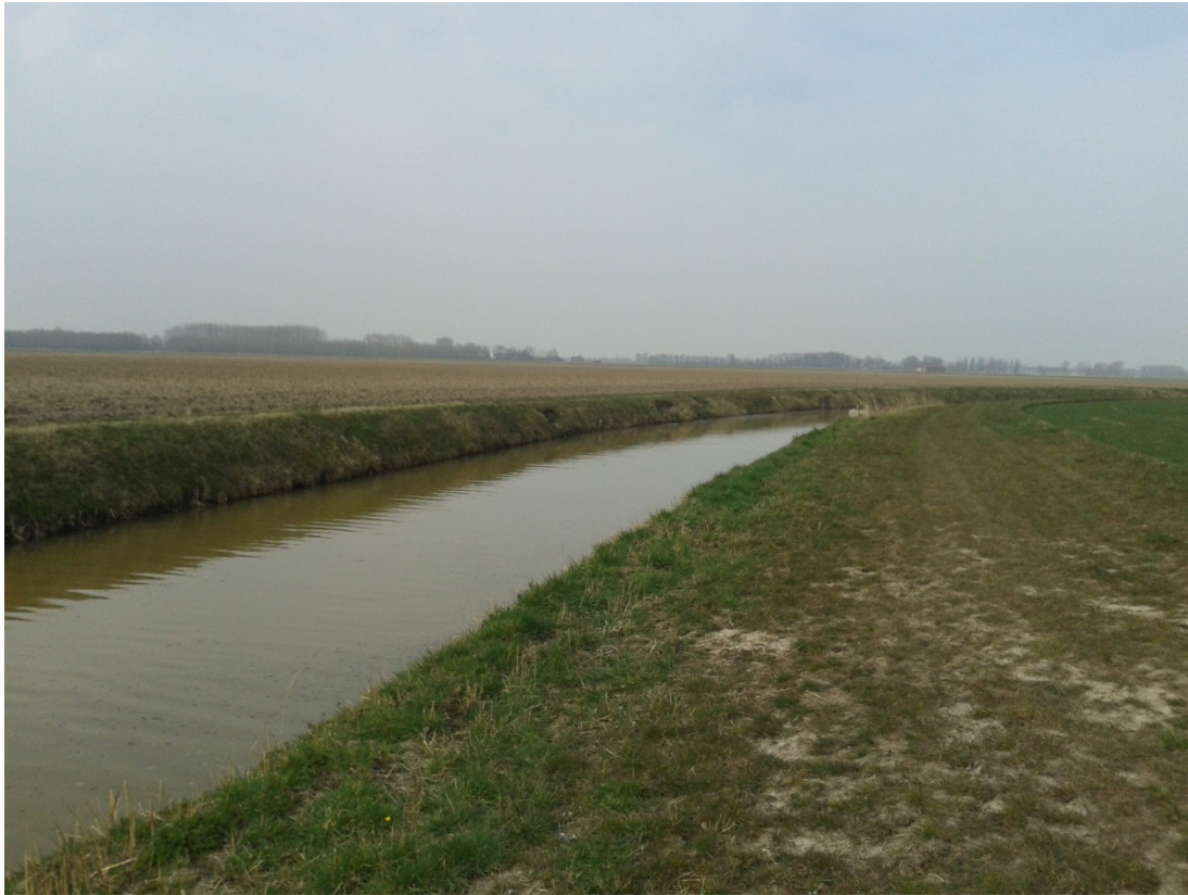
Figuur 2.6: de gekanaliseerde Bleeke Kil langs deelgebied 3.
