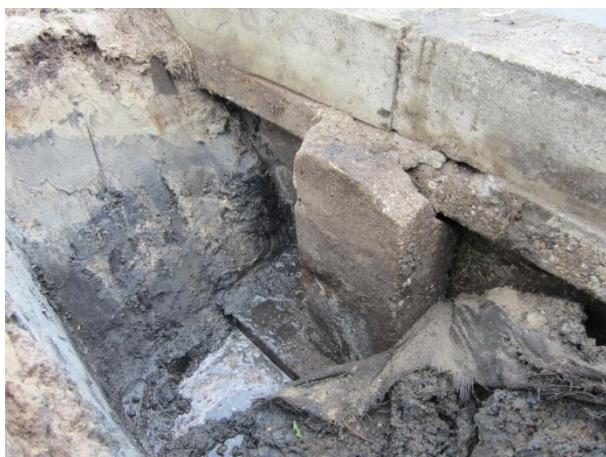
Figuur 6.3: Locatie B: Achterzijde constructie.
