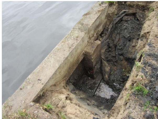
Figuur 6.2: Locatie B: Vrij gegraven tot grondwater.
