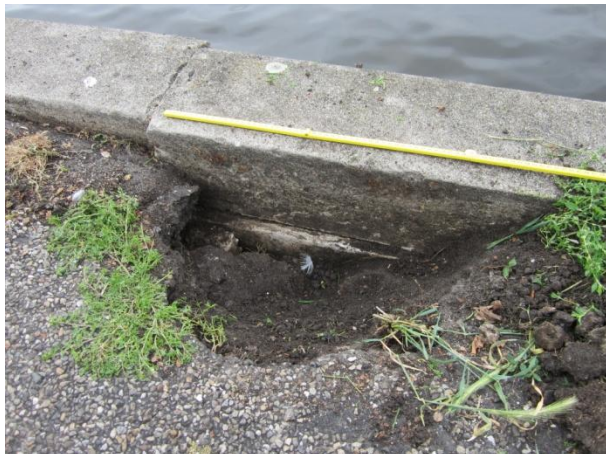
Figuur 6.1: Locatie A: Uitgespoelde dilatatievoeg.
