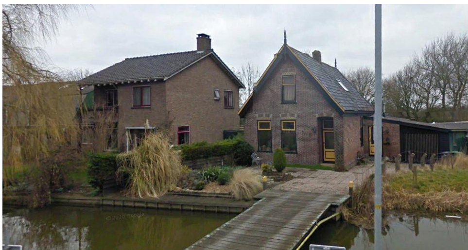
Afb. 5 Bestaande bedrijfswoning op nr. 59 (links) en de buurhuis
