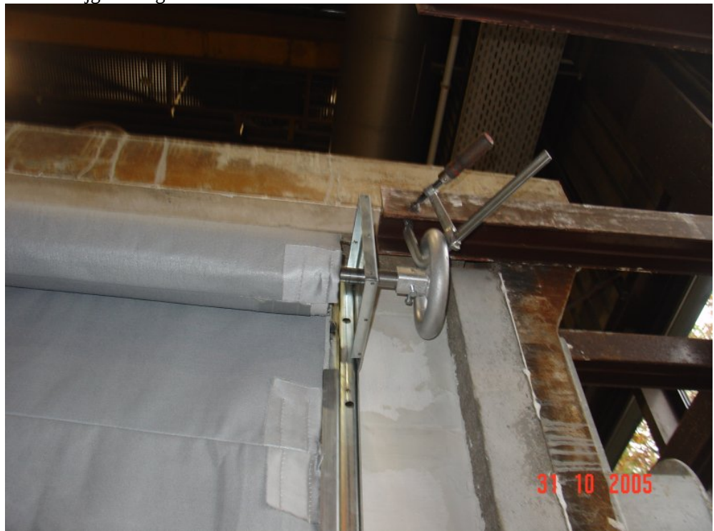
Foto 2: Ophangsysteem en motoraansluiting voor de rol.
