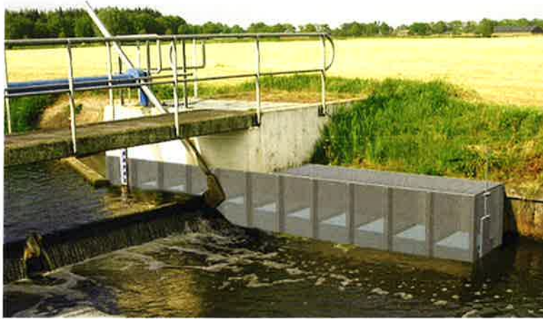
De Witvispassage geplaatst bij een bestaande stuw.
