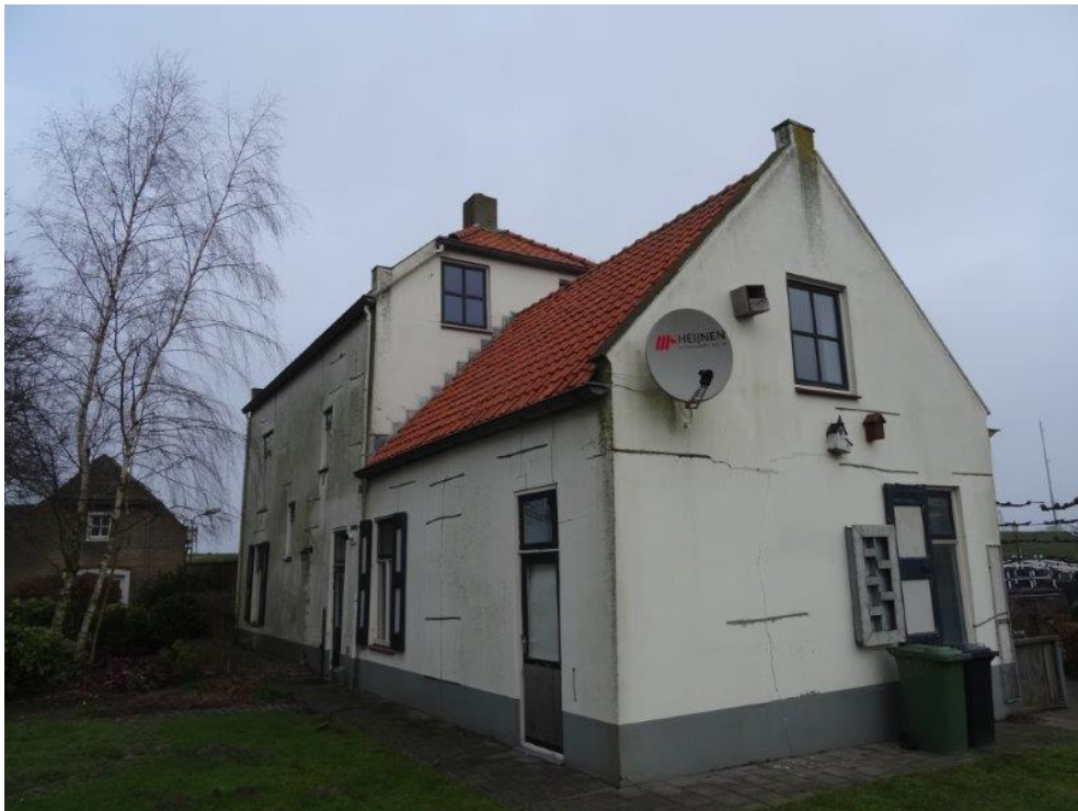
Oost en Zuid gevel
