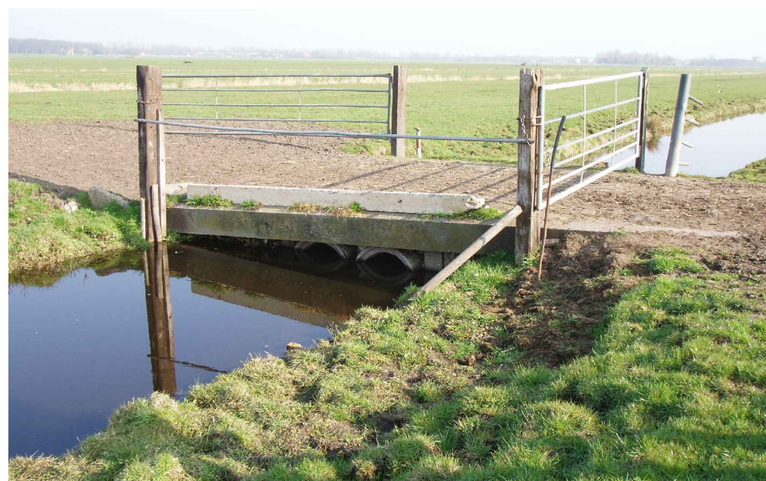
foto bestaande duiker zuidwestzijde
