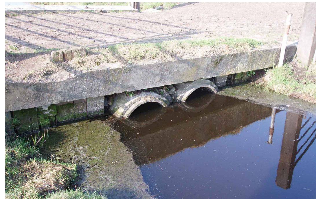
foto bestaande duiker noordoostzijde
