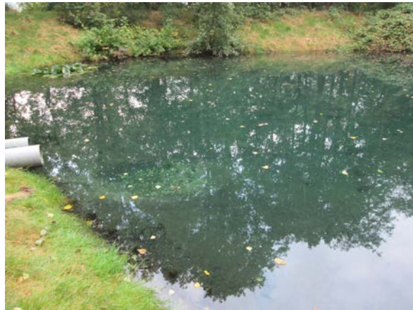
Foto 4: Lozingspunt schoonwater bedrijfsriolering op oppervlaktewater (retentievijver op terrein Denkavit met overloop naar sloot langs de Gruttoweg)
