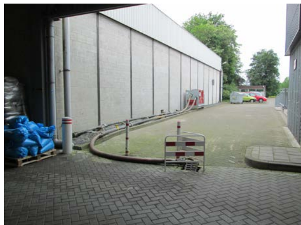
Foto 2: Pomp en lozingspunt op schoonwaterriolering tijdens bemaling kleine kelder
