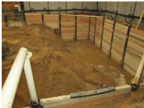
Foto 8: Tijdens ontgraving grote kelder voor aanleg van de drains (water onderin de put)
