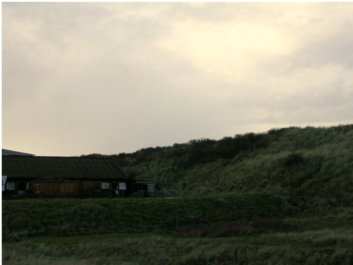
De huidige manege gezien vanaf de oostzijde.
