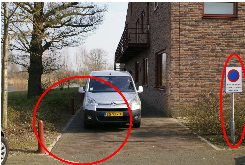
Foto 29: Verbreed pad noordzijde gebouw B (Apotheek) met verplaatste aanrijdpalen en verkeersbord
