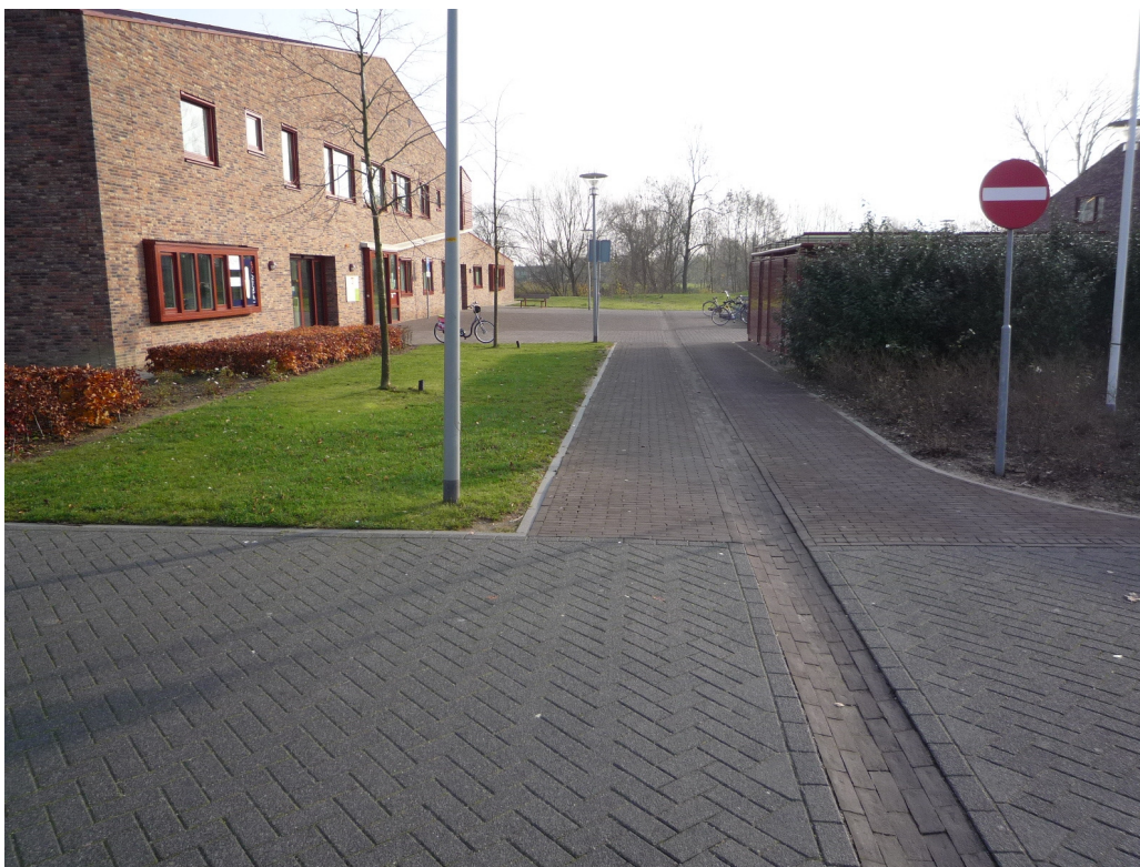
Foto 39: Overzicht verharding en groenstrook ten zuiden van gebouw B
