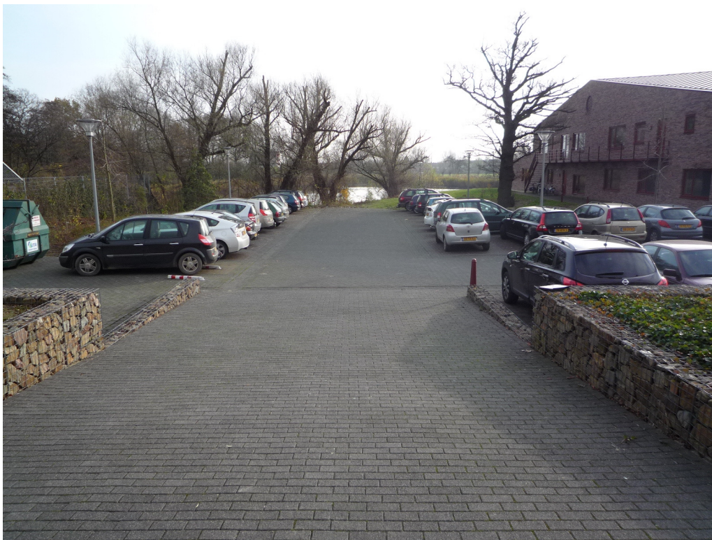
Foto 28: Overzicht parkeerplaats vanaf inrit naar gebouw A
