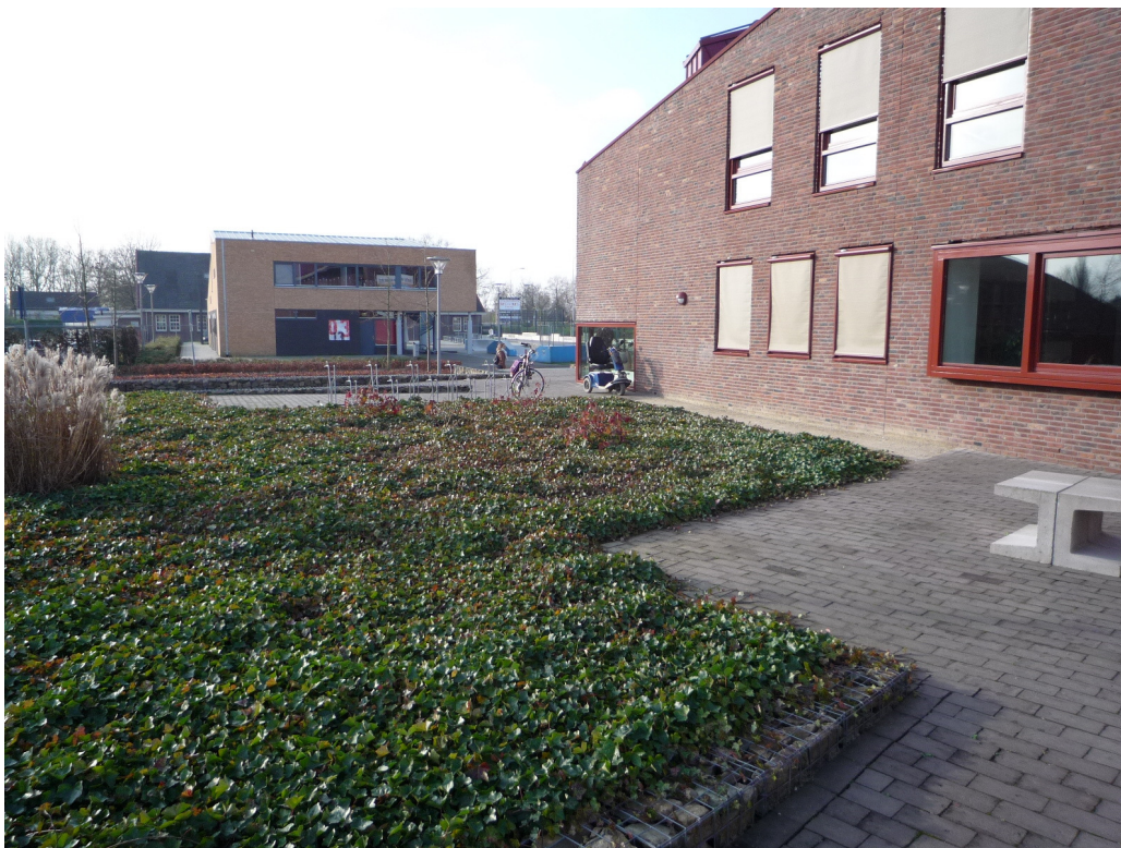
Foto 32: Overzicht achterzijde gebouw A
