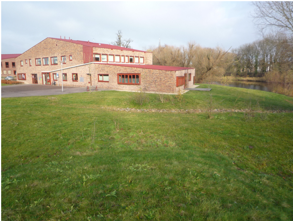
Foto 23: Overzicht groenstrook richting gebouw B
