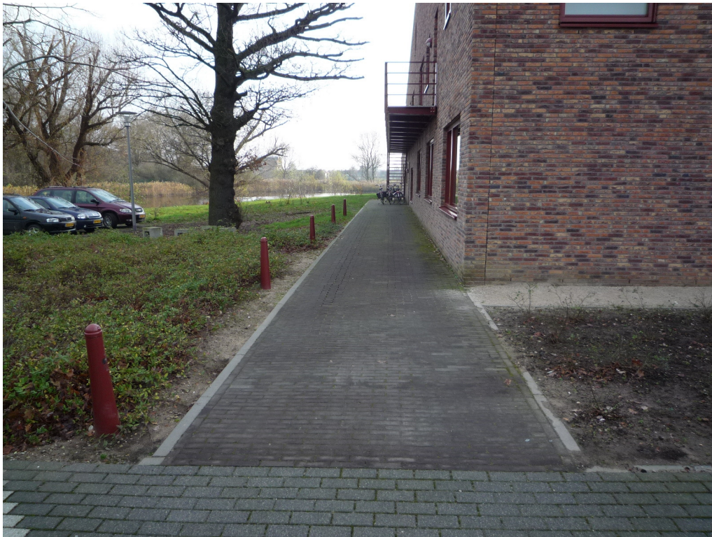
Foto 29: Overzicht groenstrook en voetpad noordzijde gebouw B
