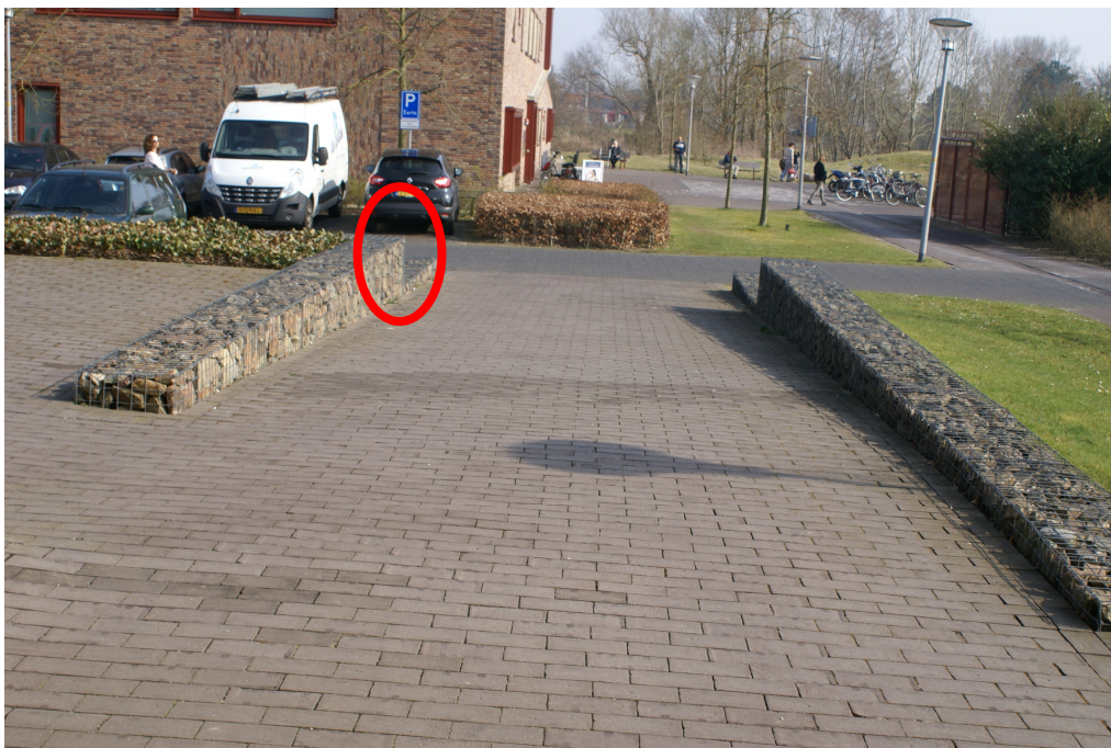
Foto 33: Verwijderde aanrijdpaal entree gebouw A richting gebouw B
