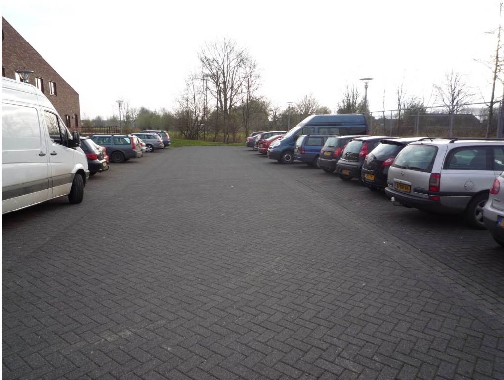
Foto 16: Overzicht verharding parkeerplaats achterzijde gebouw C
