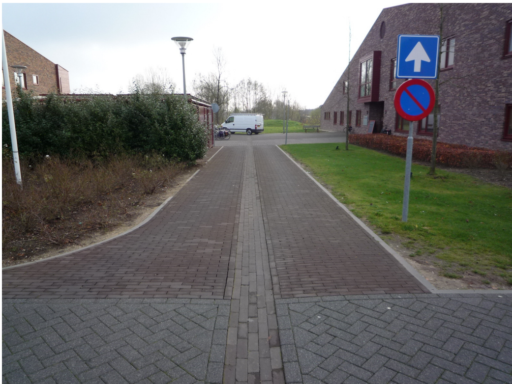
Foto 38: Overzicht verharding ten noorden van gebouw C
