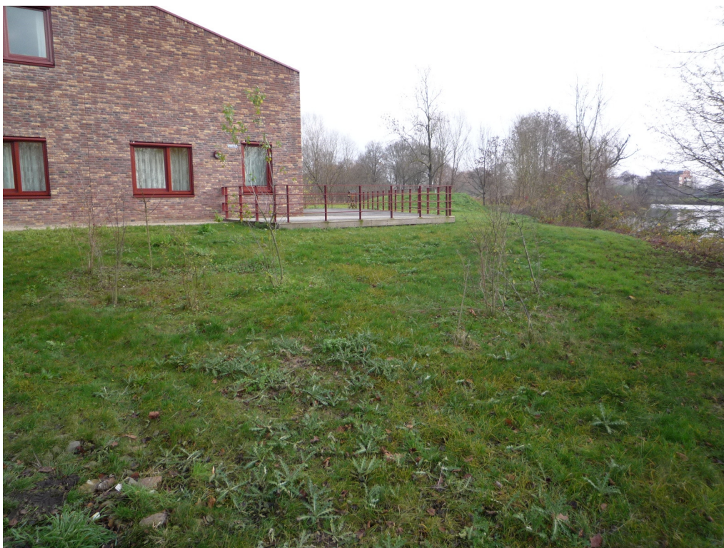
Foto 19: Overzicht groenstrook tussen gebouw C en 'Dode arm Oude IJssel'
