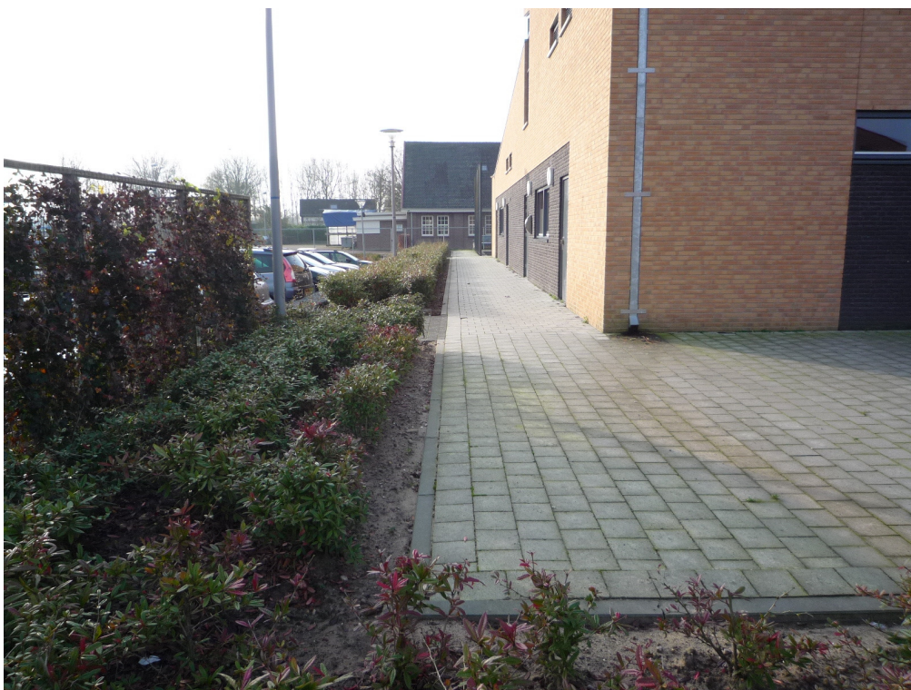
Foto 10: Overzicht verharding en groenstrook naast gebouw D vanaf midden 'De Linie' richting 'Exercitieloods'
