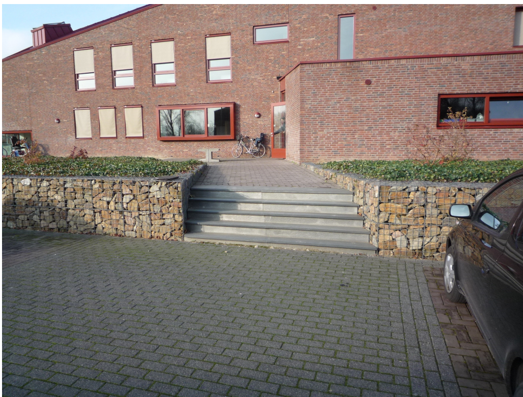
Foto 31: Overzicht situatie achterzijde gebouw A
