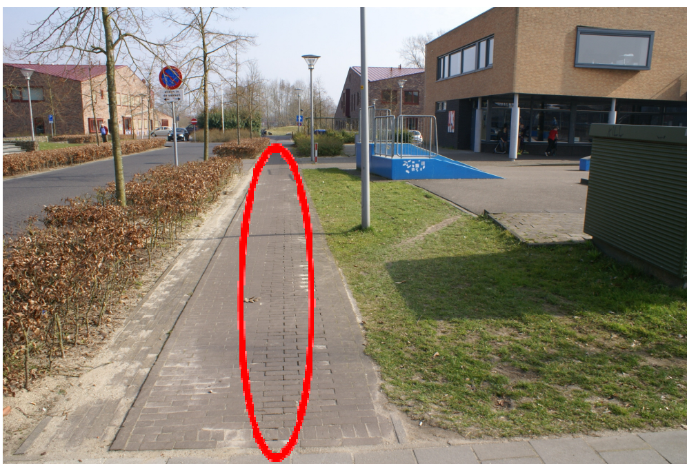
Foto 07: Opgenomen klinkers tpv voetpad/kabelstrook tussen 'De Linie en skatebaan/gebouw D
