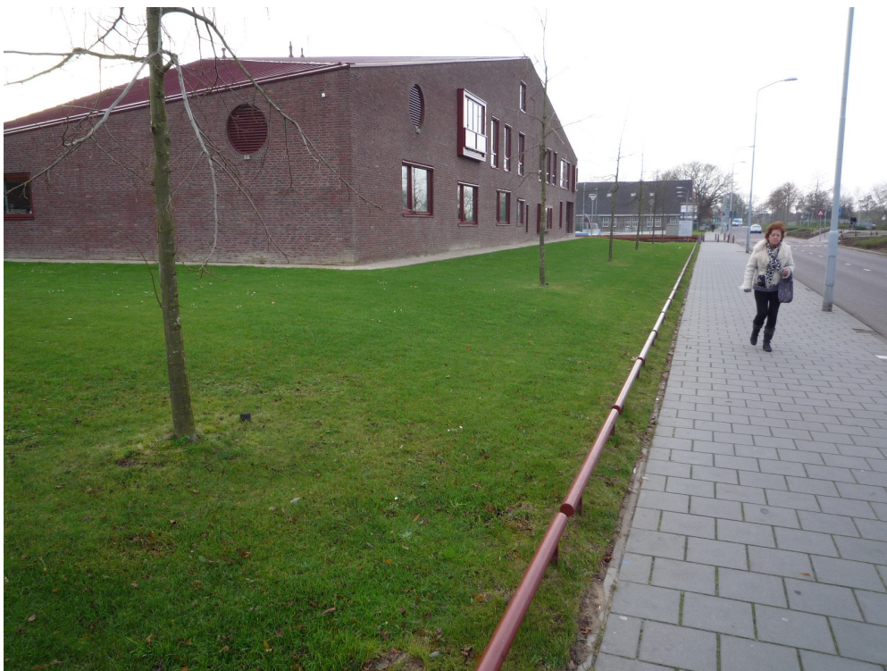
Foto 02: Overzicht vanaf Barend Ubbinkweg, langs gebouw A aan voorzijde terrein
